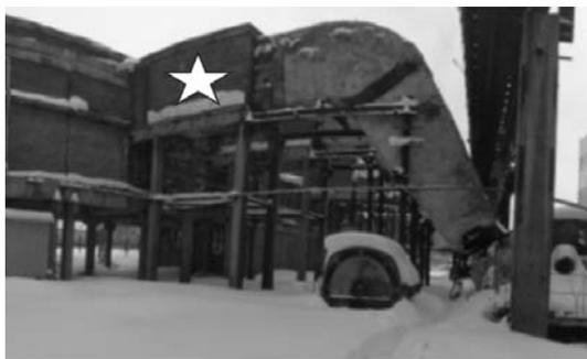
Рис. 1. Существующий газоход котла после одного из его дымососов. Звездочкой показано планируемое место монтажа теплообменника.
